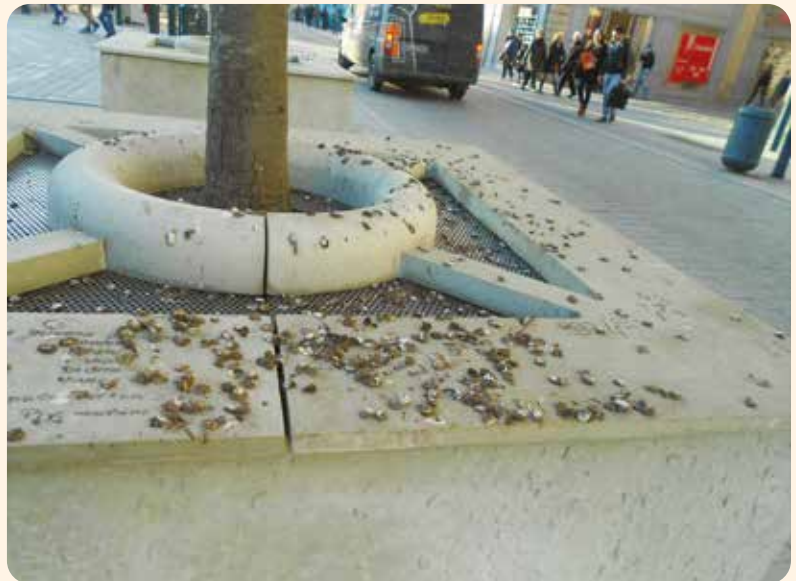
Les dégâts des étourneaux, Place de la République
