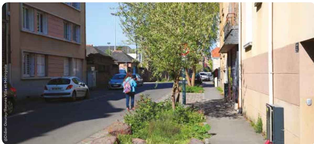
Rue Alphonse Guérin, les eaux de pluies sont drainées vers ces noues et peuvent s'y infiltrer
