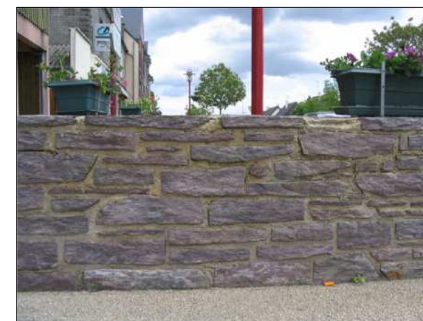
Matériaux utilisés pour les parements des murets techniques : schiste rouge
