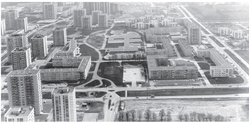
L'avenue des Pays-Bas à l'origine du quartier dans les années 1970.
