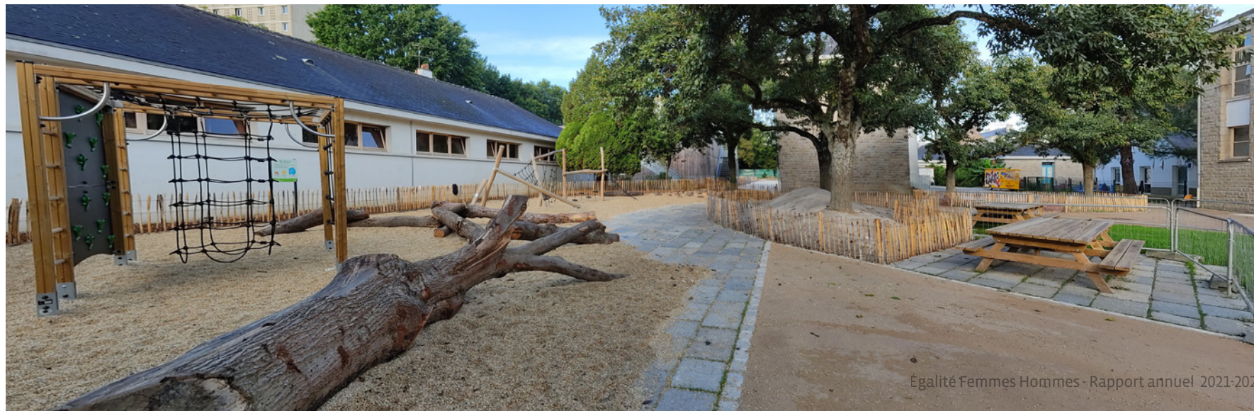
Groupe scolaire Clémenceau : chantier en cours - © Photo : DJB 4 000 m 2 de surface réaménagés pour le groupe scolaire Clémenceau
