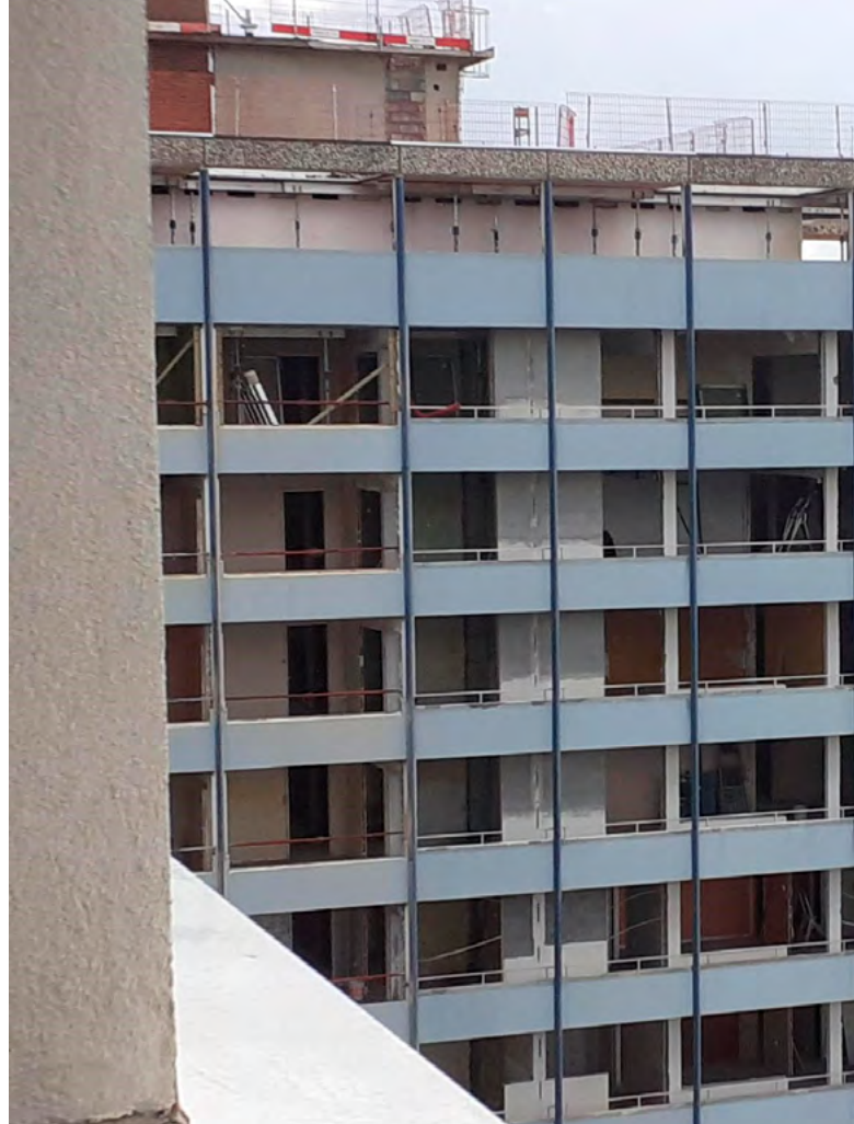
^ Des travaux d'envergure menés par Archipel Habitat pour les logements de ses tours 5 et 7
