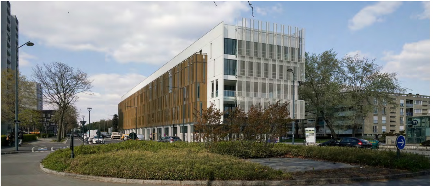
^ Le nouveau bâtiment du Quadri au Bloisne
