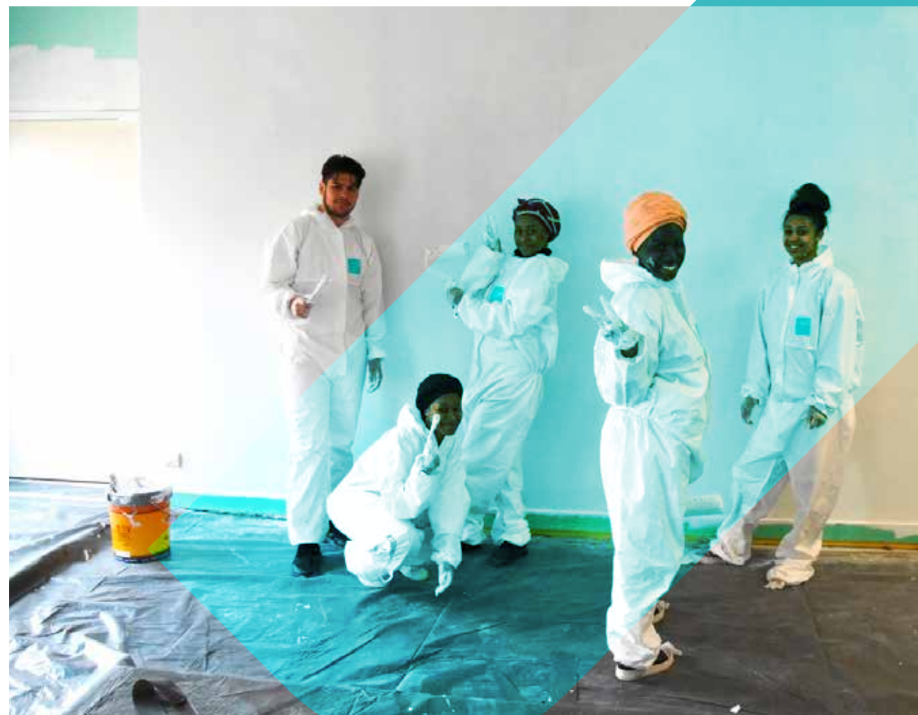
Chantier citoyen à la Maison Francisco Ferrer, avril 2019 © Catherine Péron / Rennes Ville et Métropole
