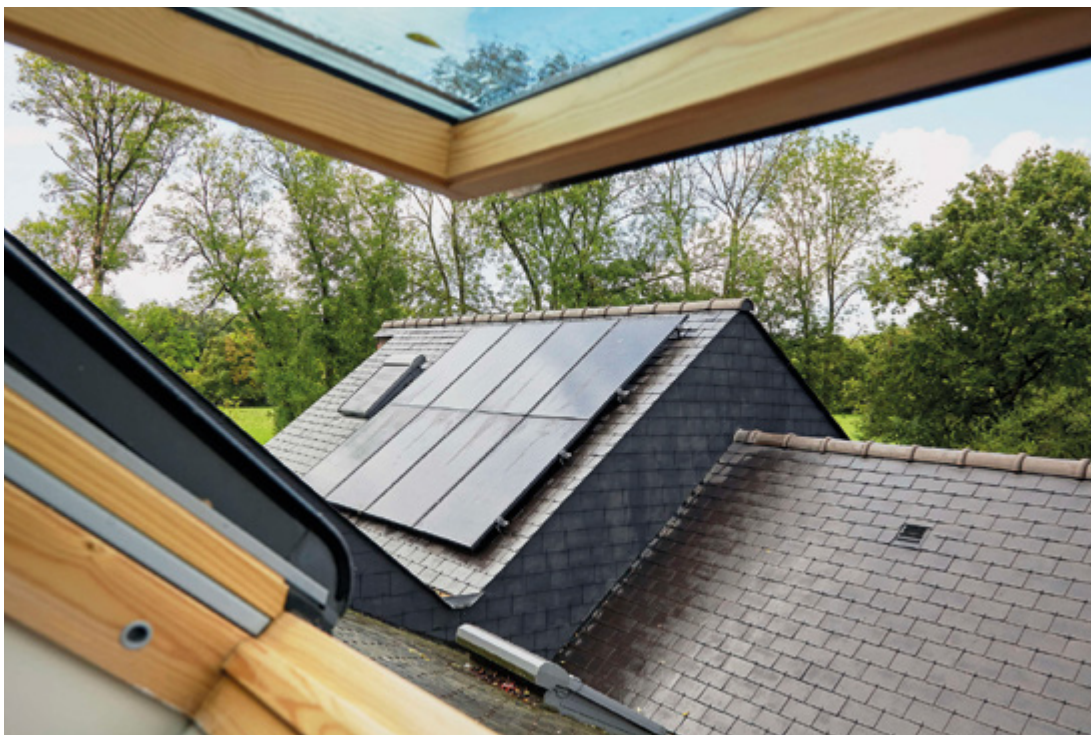
Afin de soutenir le déploiement des énergies renouvelables sur le territoire métropolitain, une modélisation 3D a été utilisée pour créer un « cadastre solaire », qui permet à chaque habitant d'évaluer le potentiel de production photovoltaïque de sa toiture © Christophe Le Dévéhat / Rennes Ville et Métropole
