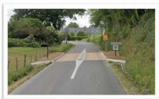
Bordures et marquage au sol pour marquer l'entrée d'agglomération
