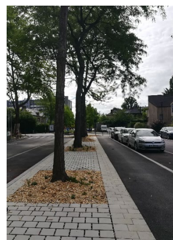
Ci-dessus : 2 à 3 rangs de pavés le long des stationnements pour protéger les plantations. Bd Emmanuel Mounier, Rennes Ci-contre : des bulbes dans des aplats de vivaces
