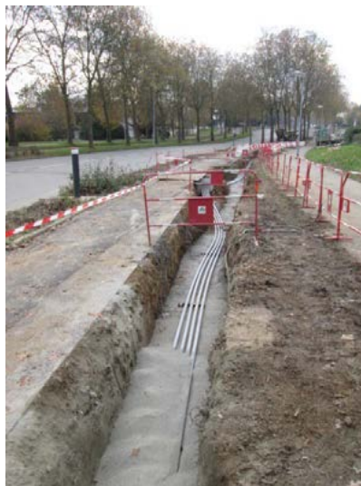
Photo du réseau dans son environnement immédiat
