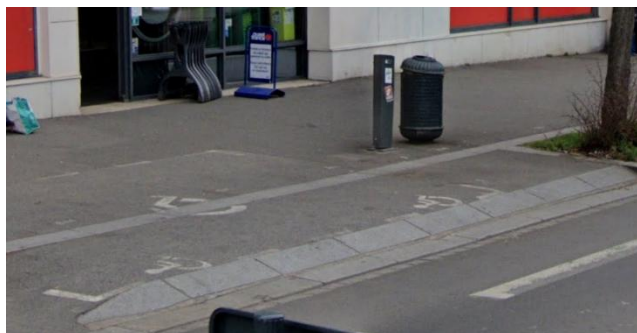
Exemple d'aménagement de bordures permettant de conserver un fil d'eau et un passage d'entrée de charretière.
