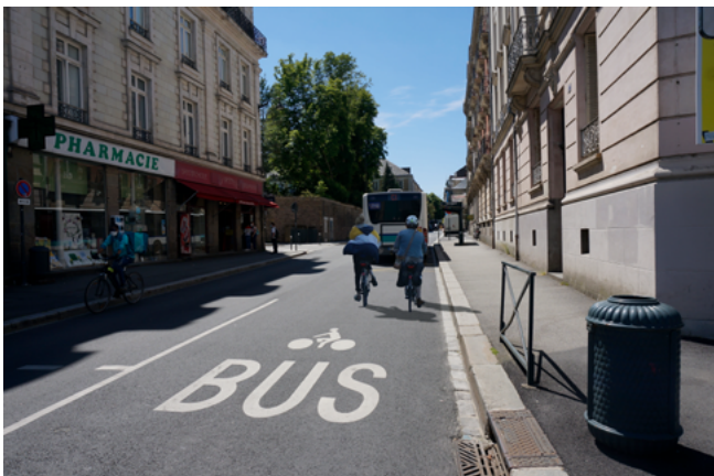
▲ Couloir mixte de largeur 3.50 m, Avenue Guillaudot
