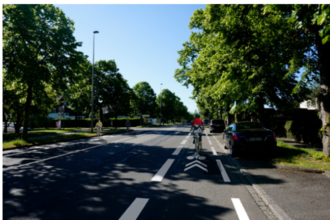
▲ Bande cyclable le long d'un stationnement longitudinal, avenue du Gallet
